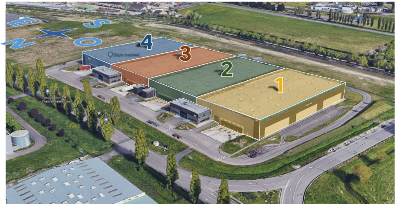
Photographie 1 : Vue aérienne de l'entrepôt et des cellules (source : Google, BEA-RI)
