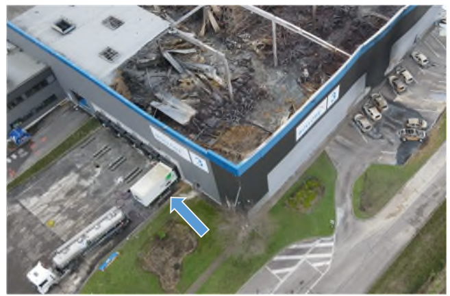
Photographie 7 : Remorque réfrigérée servant à la mise en sécurité des modules présentant des signes de dangerosité (Préconisation du fabricant Blue Solutions)
