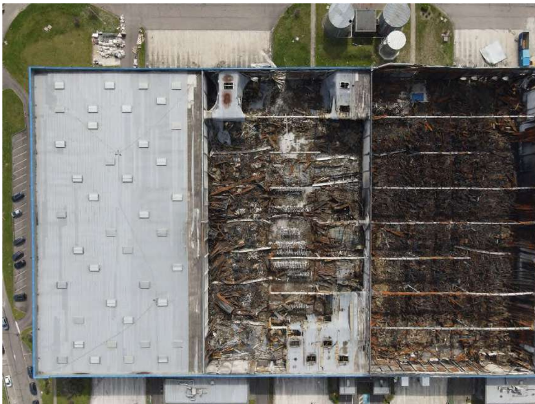
Photographie 2 : Vue des cellules 4, 3 et 2 (de gauche à droite)
