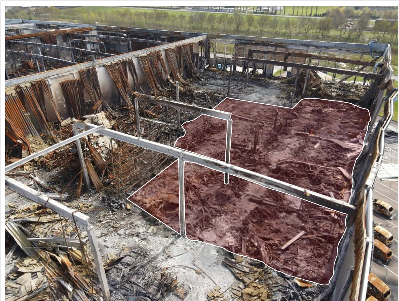
Photographie 11 : Vue de la cellule 1. En Rouge, la zone au sein de laquelle les traces d'incendie sont le plus marquées (disparition quasi totale des racks et des éléments de la toiture), présence au sol d'une épaisse couche de résidus de combustion. Le mur périphérique extérieur a subi des dommages importants qui ont localement conduit à son effondrement vers l'extérieur du bâtiment (cf. Photographie 14). Les atteintes à la structure (poutre béton) sont notablement plus importantes en comparaison celles constatées sur la cellule voisine, où étaient stockés 70 000 pneumatiques.
