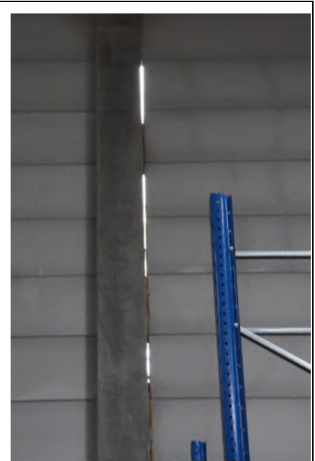
Photographie 20 : liaison poteau-mur préfabriqué.
