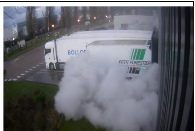
Photographie 22 : Émission de fumées en façade nord.
