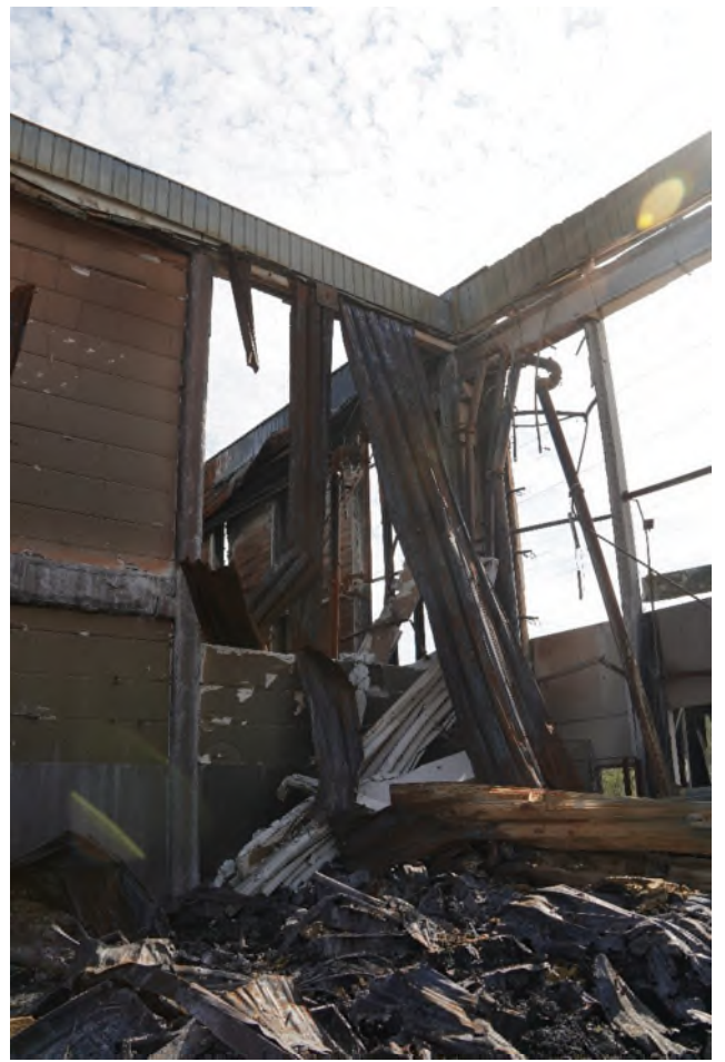
Photographie 14 : Effondrement du mur d'enceinte à l'extérieur du bâtiment en façade ouest. L'heure exacte de l'effondrement n'est pas établie.
