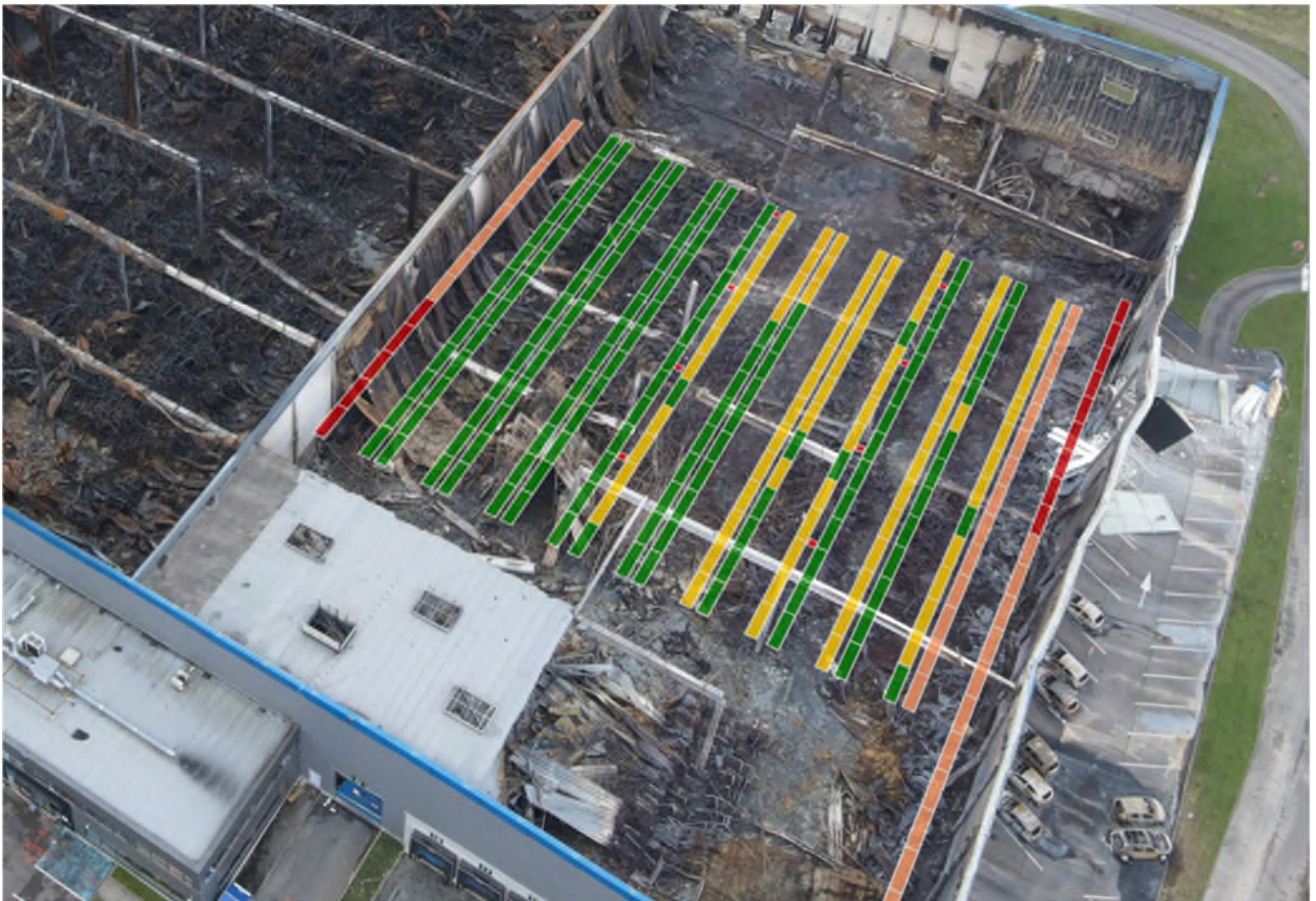
Photographie 40 : Vue de la cellule 1 et en superposition une représentation de la densité de stockage des batteries sur les différentes travées de racks. Plus la couleur est rouge plus il y a de modules dans les racks. On aperçoit la destruction partielle du mur en façade ouest à un endroit où la quantité de batteries est importante.
