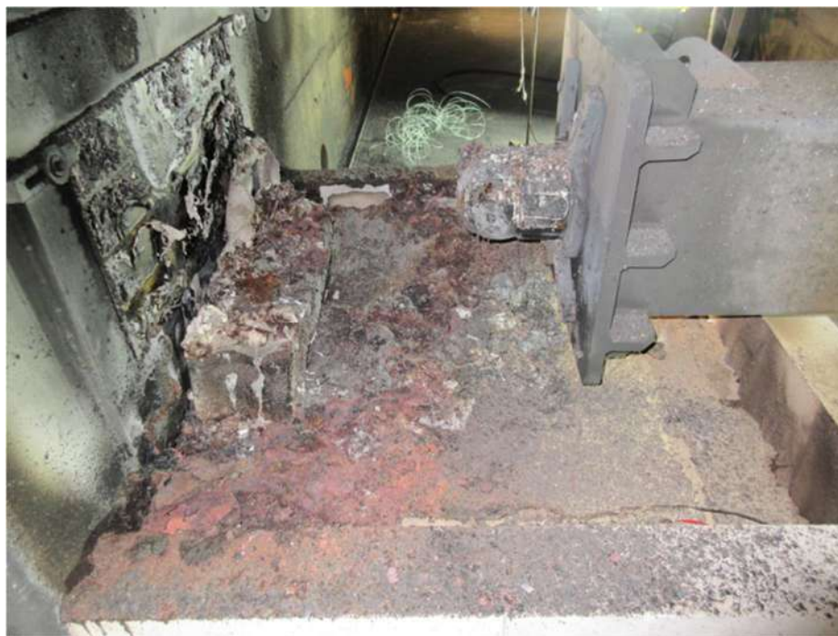
Figure 14 : Photo après essai
