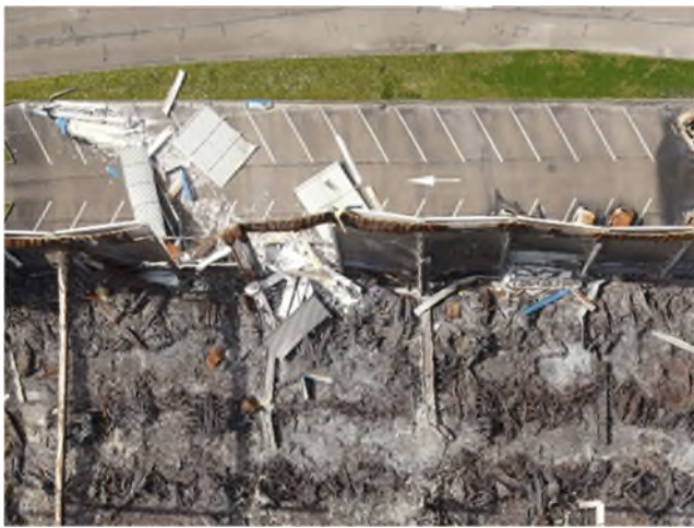
Photographie 14 : Effondrement du mur d'enceinte à l'extérieur du bâtiment en façade ouest. L'heure exacte de l'effondrement n'est pas établie.
