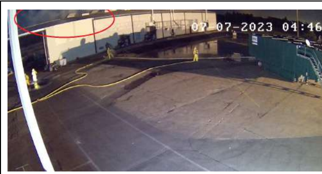
Photographie 23 : A partir de 4h35, de la fumée s'échappe en toiture du bâtiment (cercle rouge) par les exutoires de fumées
