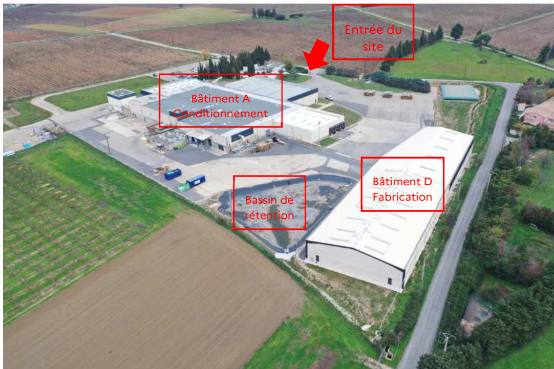
Figure 1 : Localisation des installations vue Sud-Ouest (Source HYDRAPRO)
