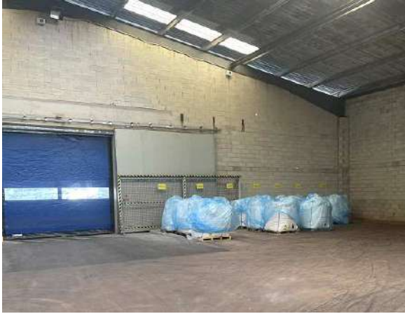
Photographie 6 : La porte latérale du bâtiment D et un stockage de big-bags sur palettes bois (Source HYDRAPRO)
