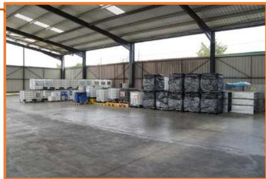
Photographie 8 : La partie droite semi-ouverte du bâtiment D, couverte par une toiture métallique (Source BEARI)
