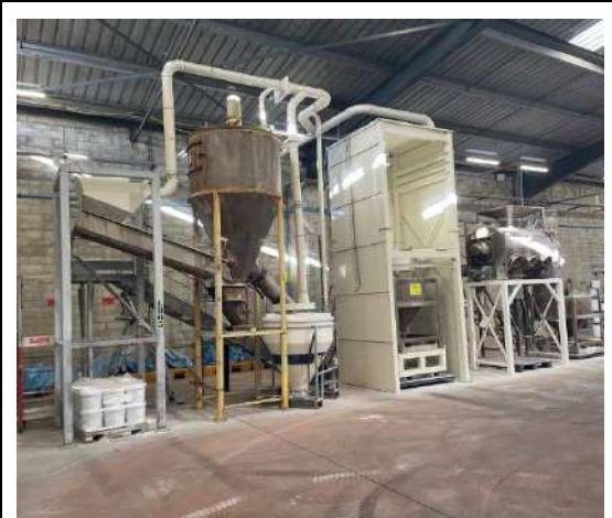
Photographie 3 : Vue d'un mélangeur au bâtiment D
