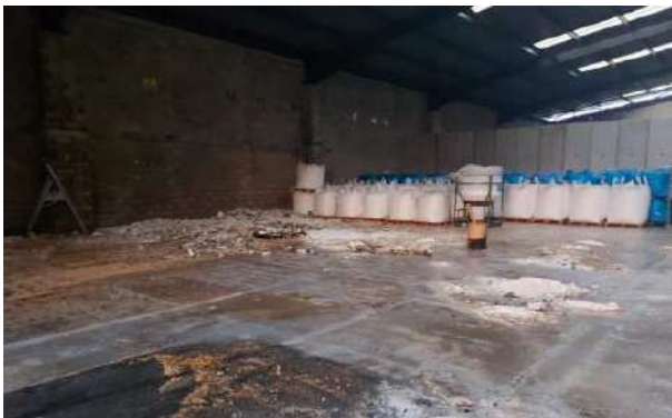
Photographie 10 : Photo de l'intérieur du bâtiment de fabrication à 6h le mercredi 5 juillet 2023 (Source : HYDRAPRO)
