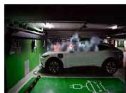
**DESAUTEL SA PROTECTION INCENDIE - EV-PROTEC** : Système de protection incendie par brouillard d'eau conçu pour maîtriser les feux de batterie de véhicules électriques et éviter la propagation au sein des parkings couverts. Il combine une technologie de brouillard d'eau déluge basse pression à un système de détection pour garantir une protection optimale et une intervention rapide et sécurisée des pompiers.
