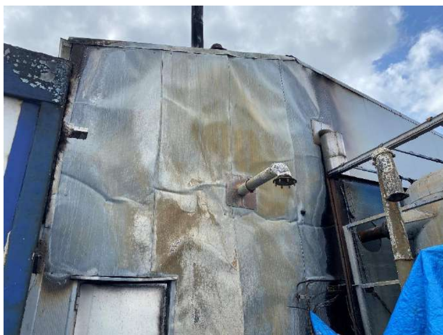
Figure n°2 : façade extérieure du bâtiment principal de l'UDP
