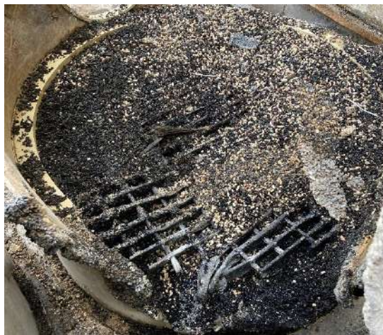
Figure n°8: grille de séparation présente au fond de la cuve
